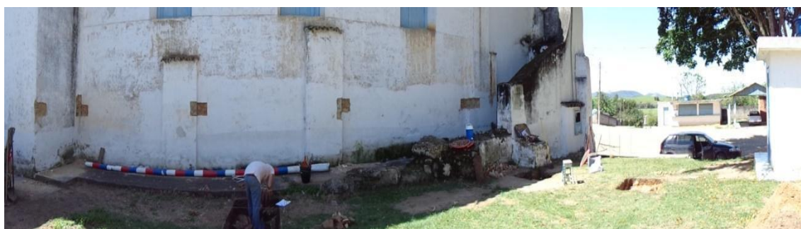
Figura 22 - Vista geral das prospecções de parede realizadas na parede lateral da nave da igreja e sacristia sendo realizadas sete prospecções para identificação de alvenaria. Fonte: Costa (2013).
