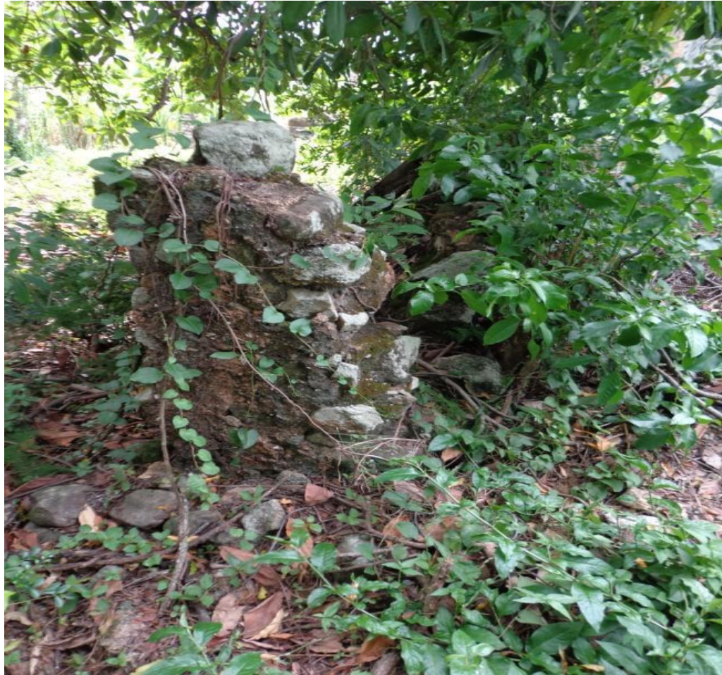
Figura 23 - Estrutura de possível acesso em ruína ao fundo da área atualmente sem construção a poucos centímetros da superfície contrapiso com distribuição regular no quadrante. Fonte: Costa (2013).
