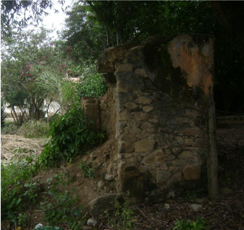
Figura 20 – Detalhe da estrutura da antiga escadaria que levava possivelmente ao primeiro pavimento que era suspenso. Fonte: Costa (2010).
