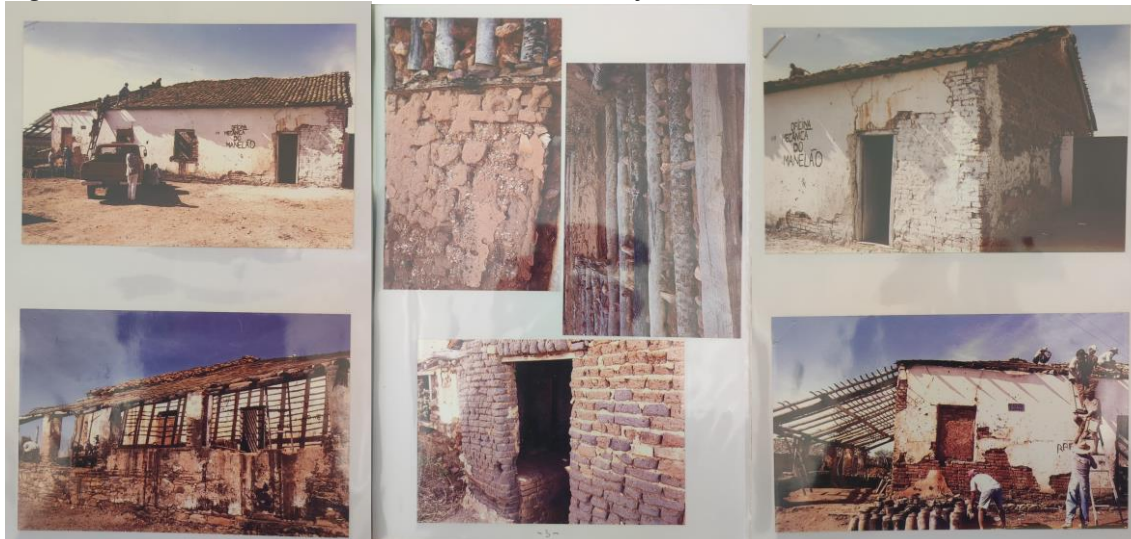
Figura 24 - Momento da derrubada da casa da Fazenda Brejo de Santo Inácio.
