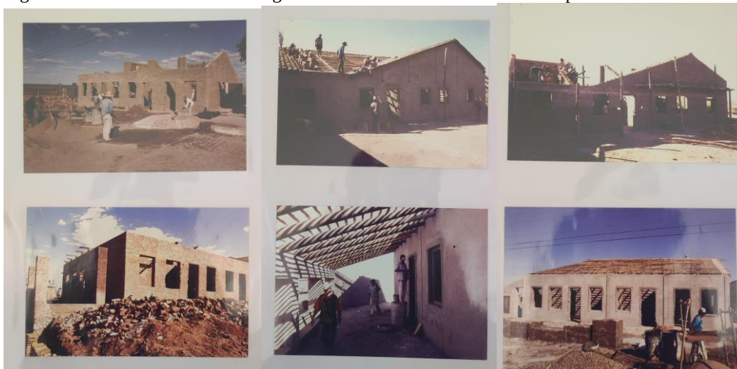
Figura 25 - Nova estrutura sendo erguida em 1989 - Casa Pastoral da Companhia de Jesus.
