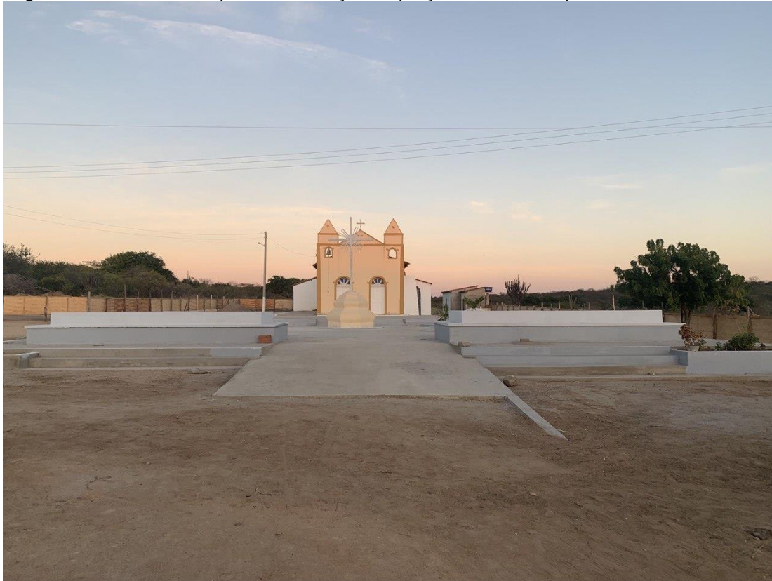
Figura 47- Vista mais ampla da construção da praça entorno da capela do Senhor do Bonfim.
