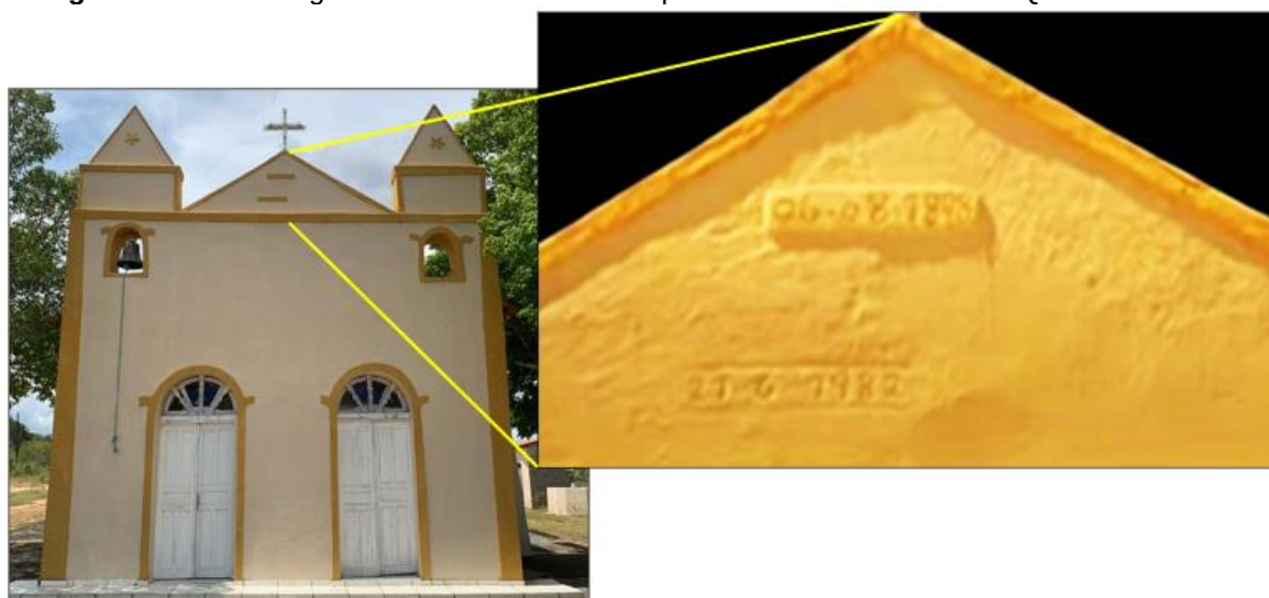
Figura 25 - Datas registradas na fachada da capela do Senhor do Bonfim- Queimadas- DA.
