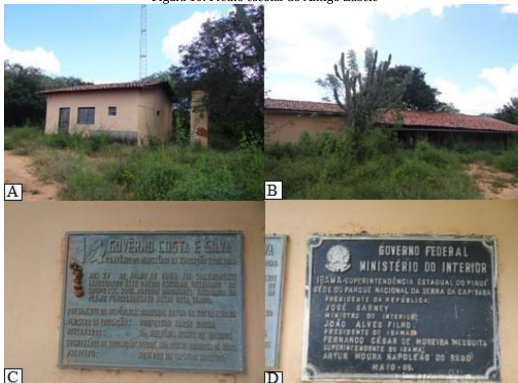
Figura 10: Prédio escolar do Antigo Zabelê
