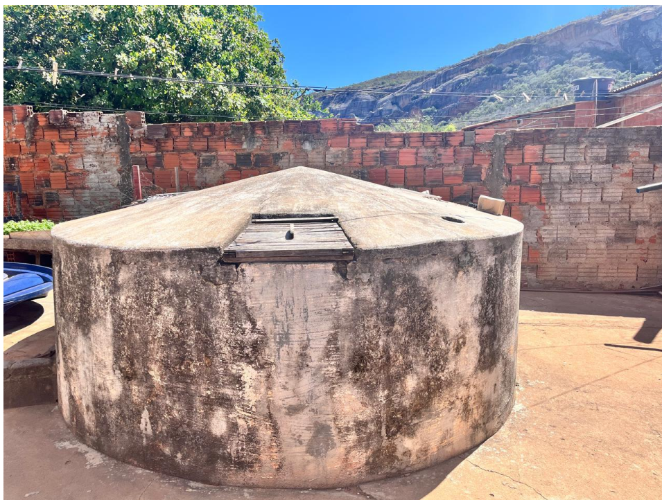
Figura 11: Cisterna da residência da Colaboradora Iolene Sousa, contemplada pelo programa social 1 Milhão de Cisterna.
