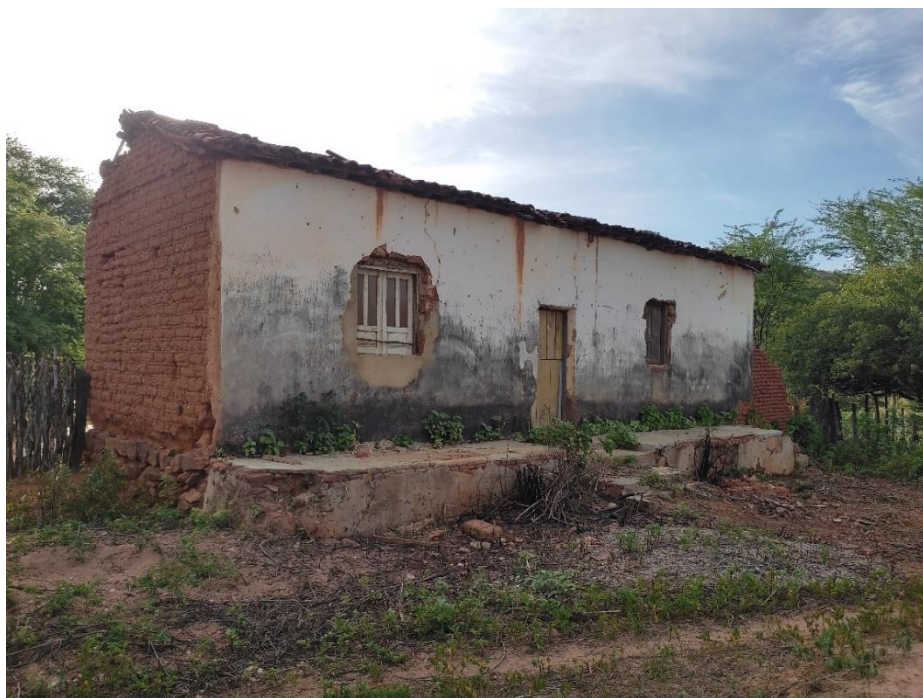
Figura 6: Antiga casa do bisavô do Sr. Carlito na comunidade Limoeiro.
