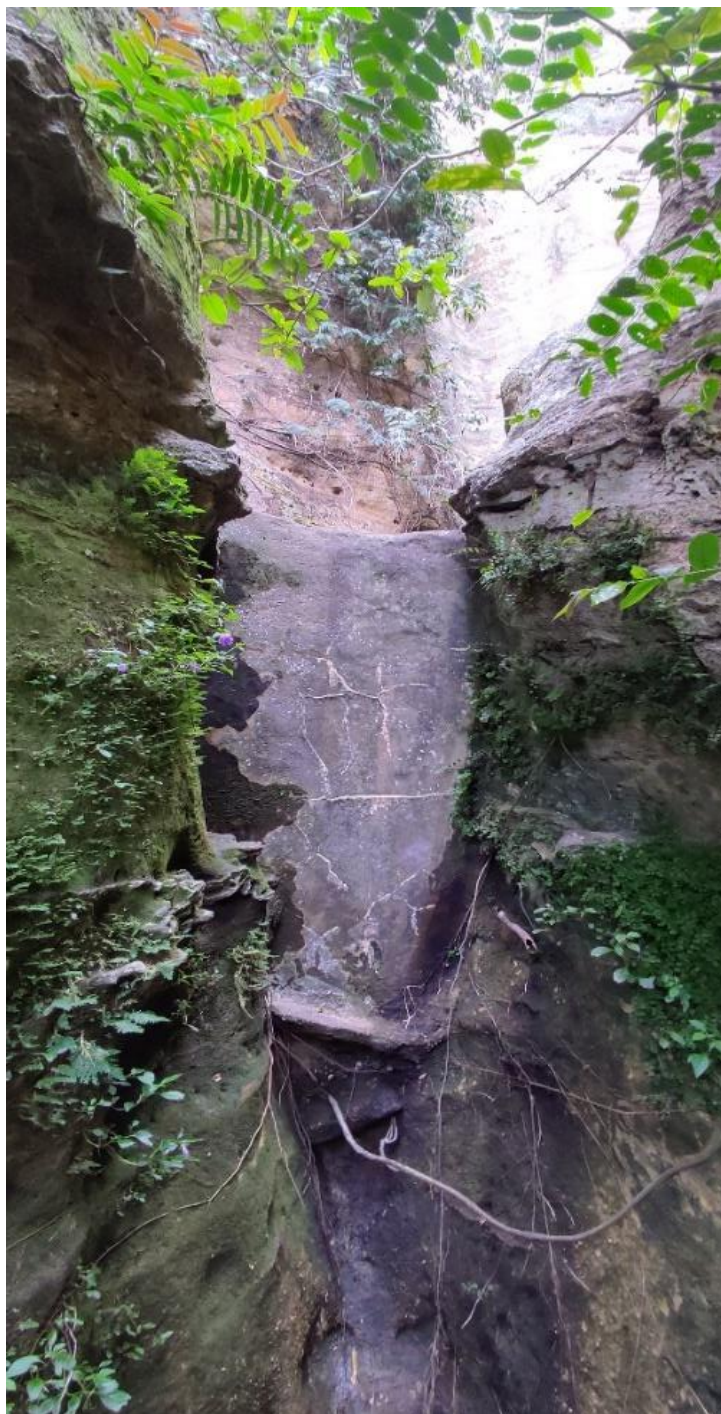
Figura 72: Parede de cimento do caldeirão do Banho.
