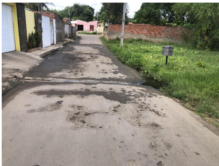
Figura 8: Valas contendo esgoto atingindo a lagoa (19/05/23)
