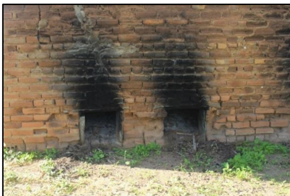
Figura 86 - Parte externa da casa de farinha contemplando os acessos para inserção da madeira (lenha)
