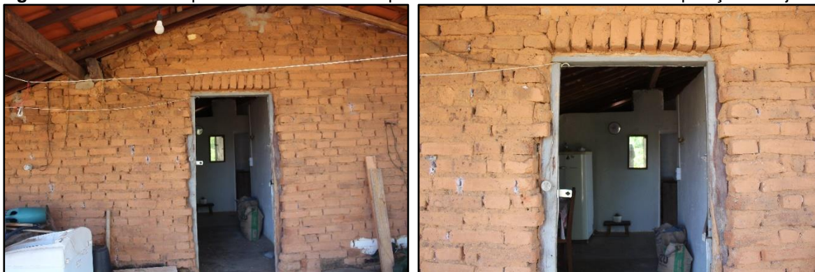
Figura 66 - Detalhe arquitetônico na lateral esquerda evidência a técnica da sobreposição de tijolos
