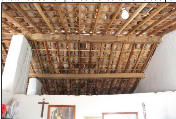
Figura 59 - Detalhe arquitetônico contemplando o encurtamento das paredes e o telhado
