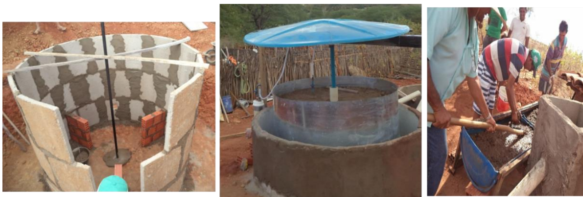
Figura 32 - Construção e manejo de biodigestores.
