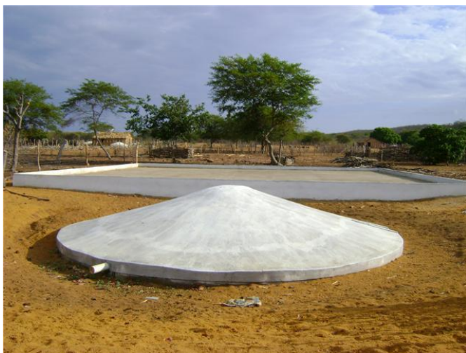
Figura 37- Cisterna calçadão e cisterna telhadão.
