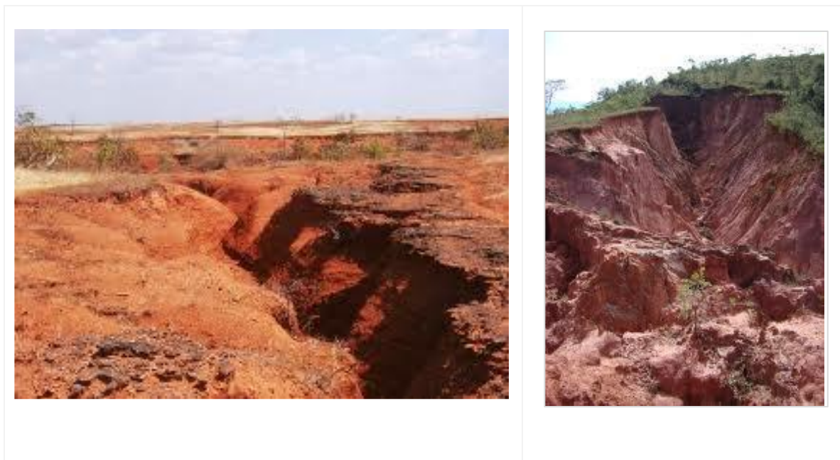
Figura 18- Exemplos de erosão em voçorocas.
