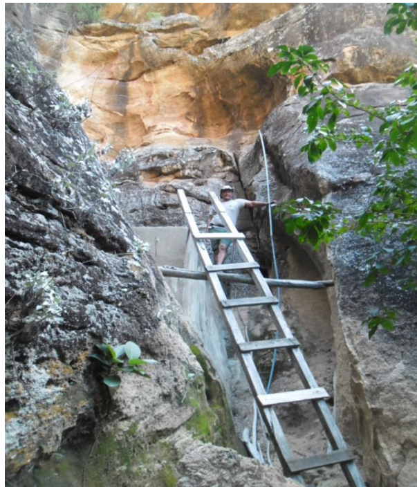
Figura 27: Escada para a manutenção do caldeirão da porta.
