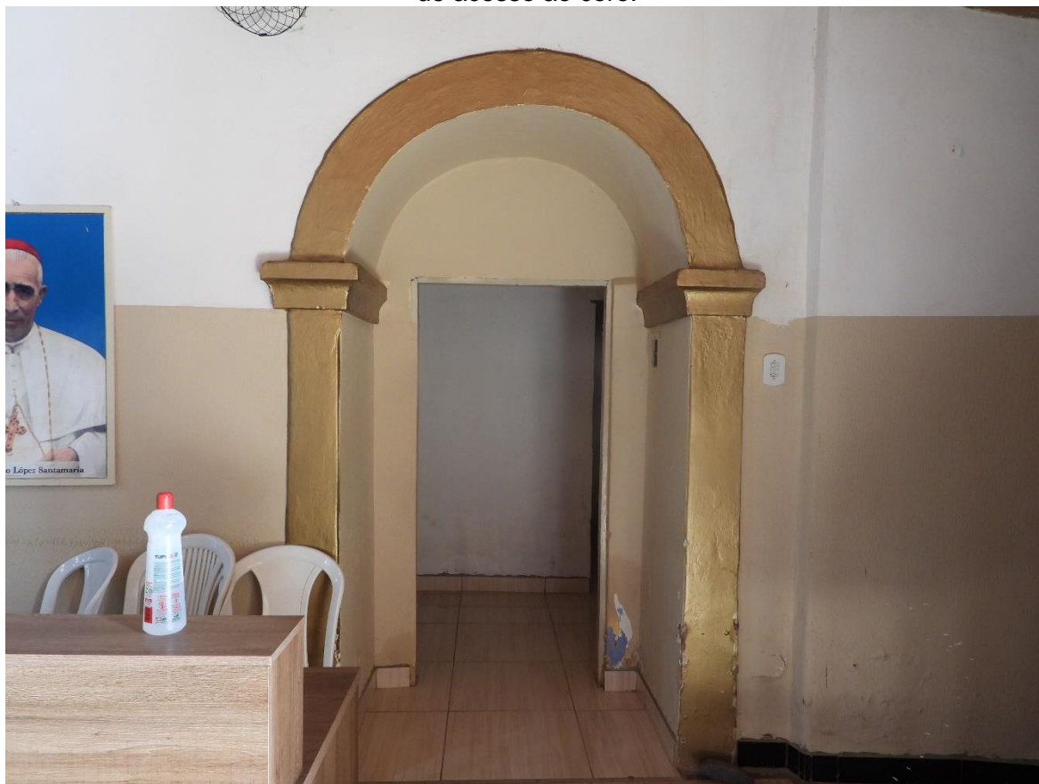
Imagem 71 - Acesso à direita da nave central ao espaço destinado a sacristia e a escada de acesso ao coro.
