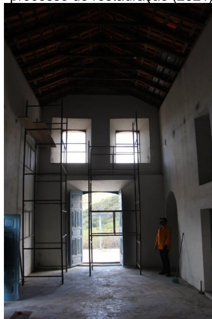
Imagem 132 - Igreja de Ponta da Serra em processo de restauração (2021).
