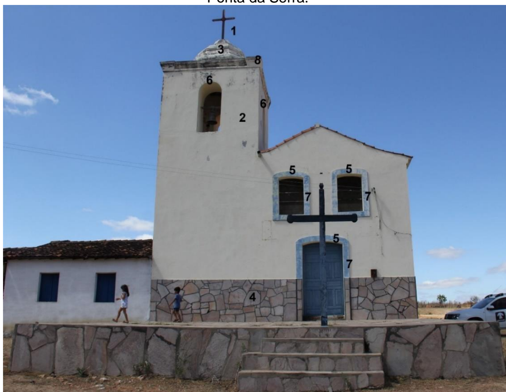
Imagem 117 - Numeração dos elementos arquitetônicos identificados na capela de Ponta da Serra.
