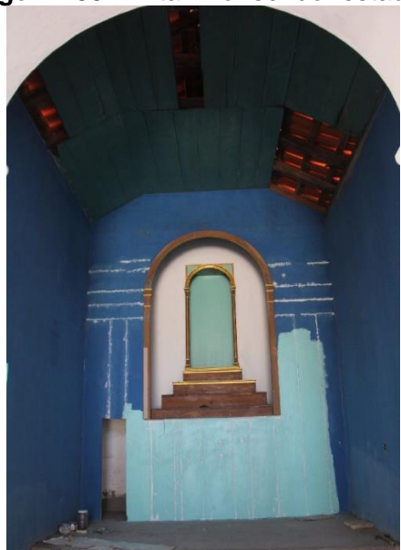
Imagem 133 – Altar-mor sendo restaurado.
