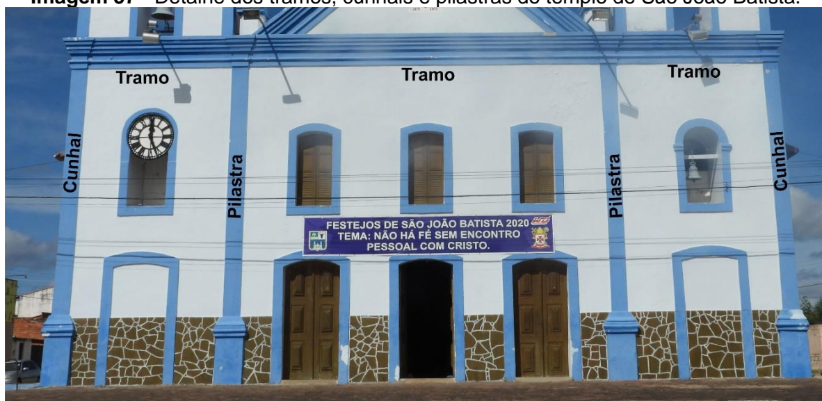
Imagem 57 - Detalhe dos tramos, cunhais e pilastras do templo de São João Batista.
