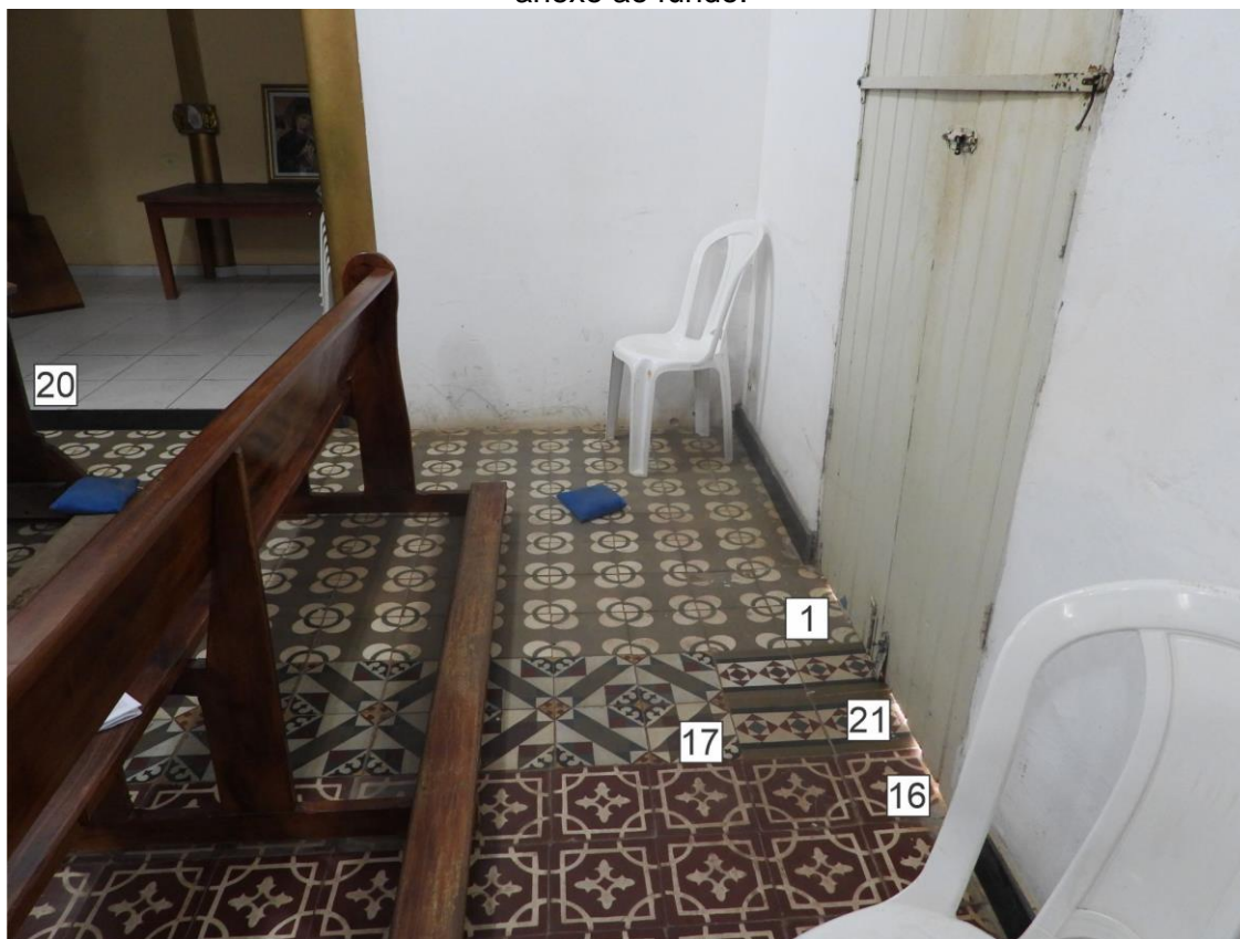
Imagem 100 - Detalhe dos ladrilhos presentes no transepto direito e piso cerâmico no anexo ao fundo.
