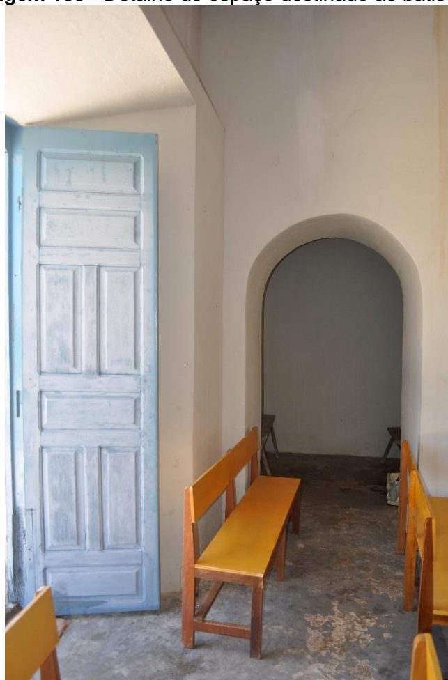
Imagem 139 - Detalhe do espaço destinado ao batistério.
