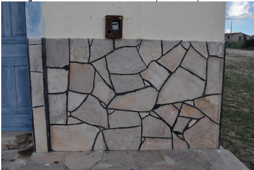
Imagem 121 - Detalhe do embasamento em pedra do templo.
