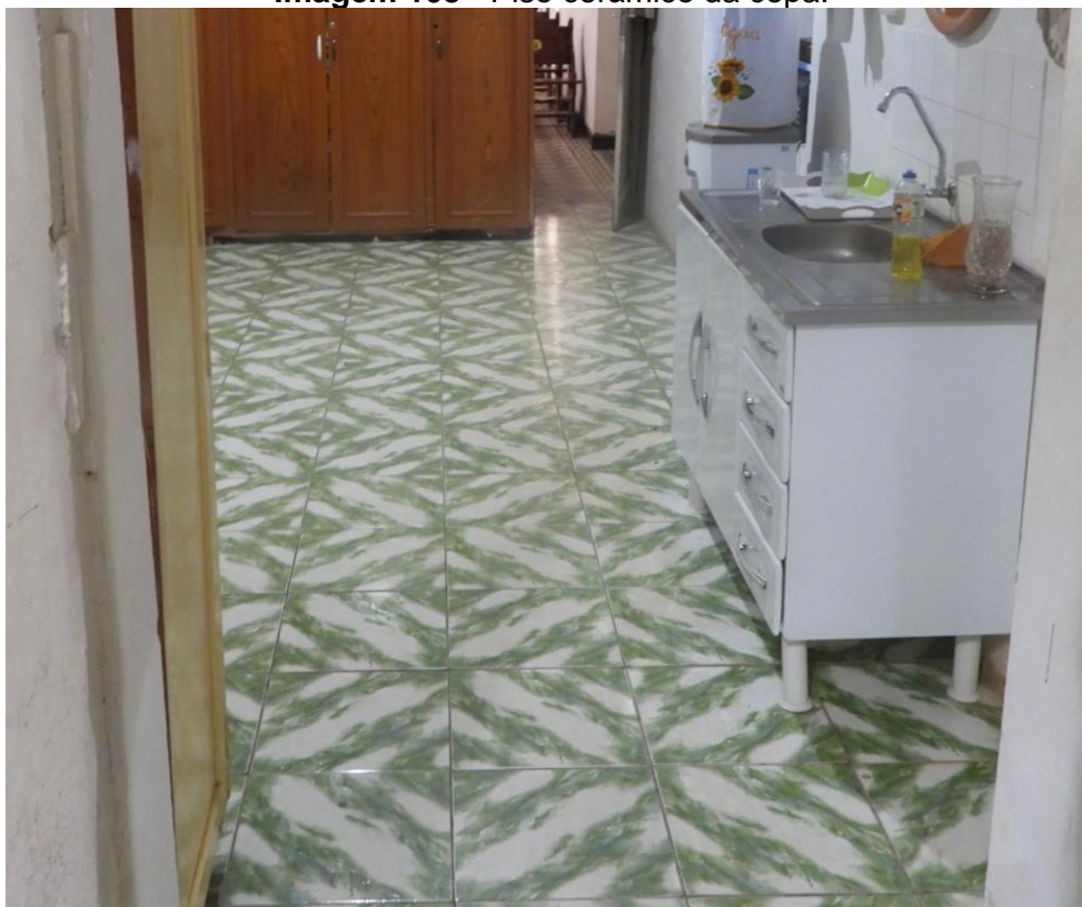
Imagem 103 - Piso cerâmico da copa.
