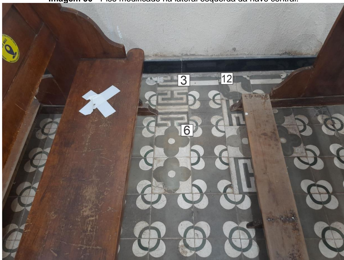
Imagem 90 - Piso modificado na lateral esquerda da nave central.
