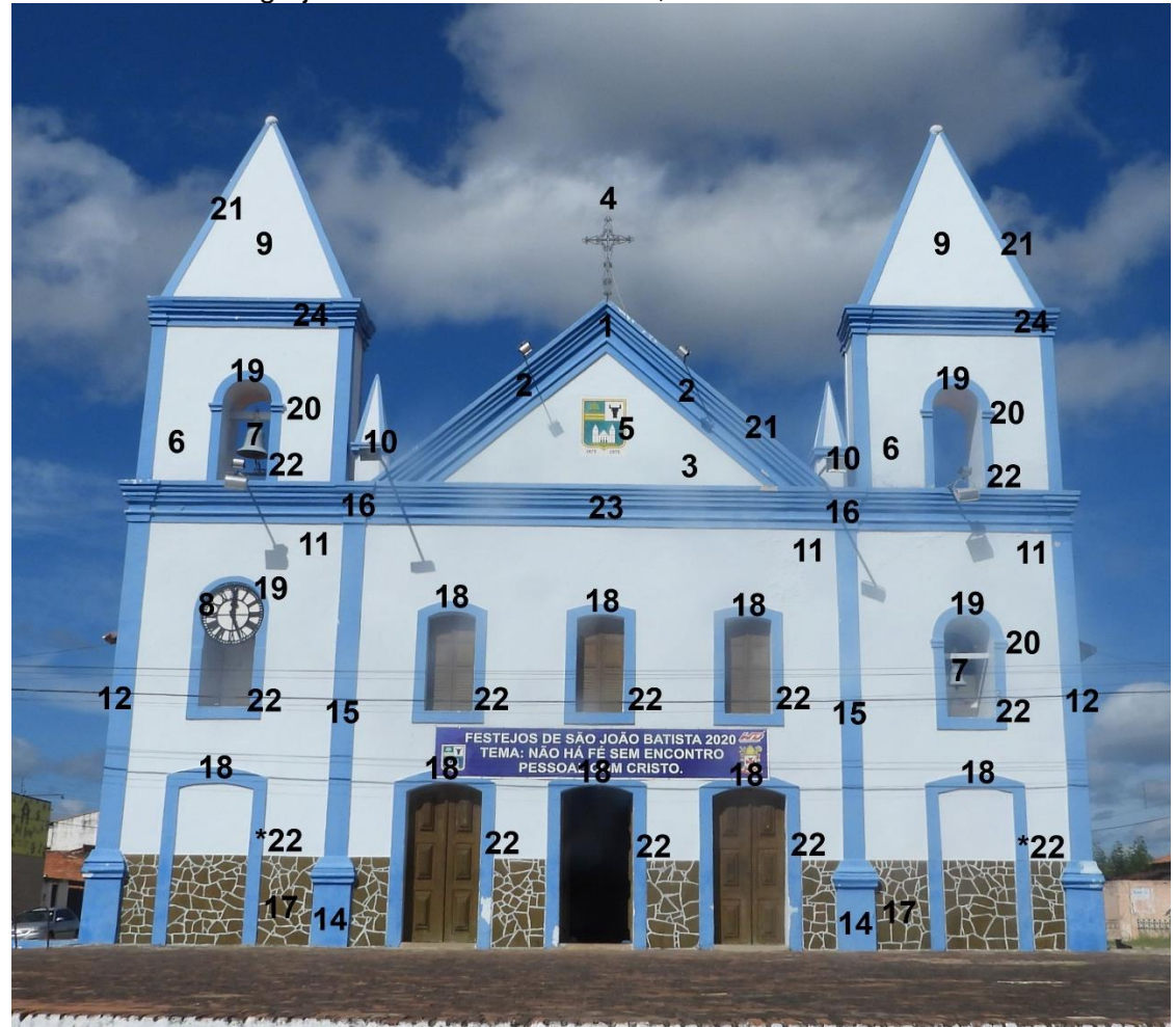
Imagem 51 - Elementos arquitetônicos e construtivos identificados na fachada da Igreja Matriz São João Batista, São João do Piauí.
