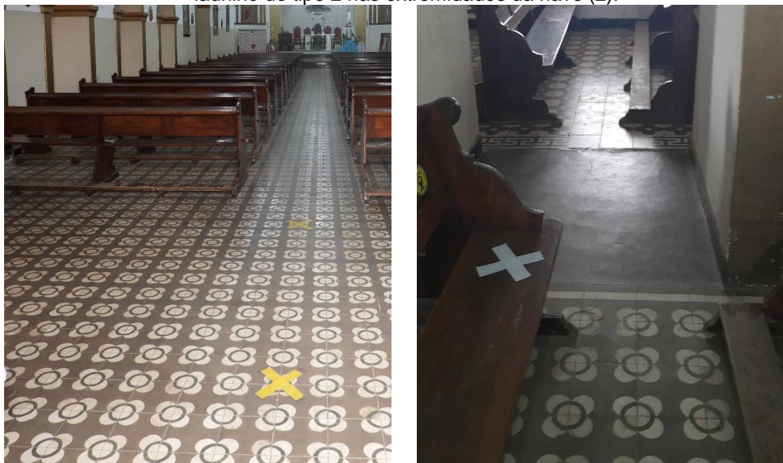
Imagem 85 - Na esquerda ladrilho hidráulico do tipo 1 presente na nave central, a direita ladrilho do tipo 2 nas extremidades da nave (2).
