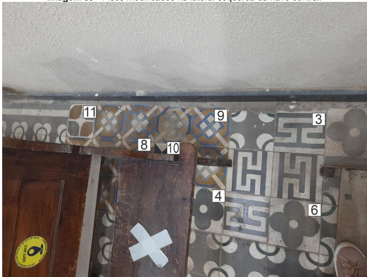
Imagem 89 - Pisos modificados na lateral esquerda da nave central.
