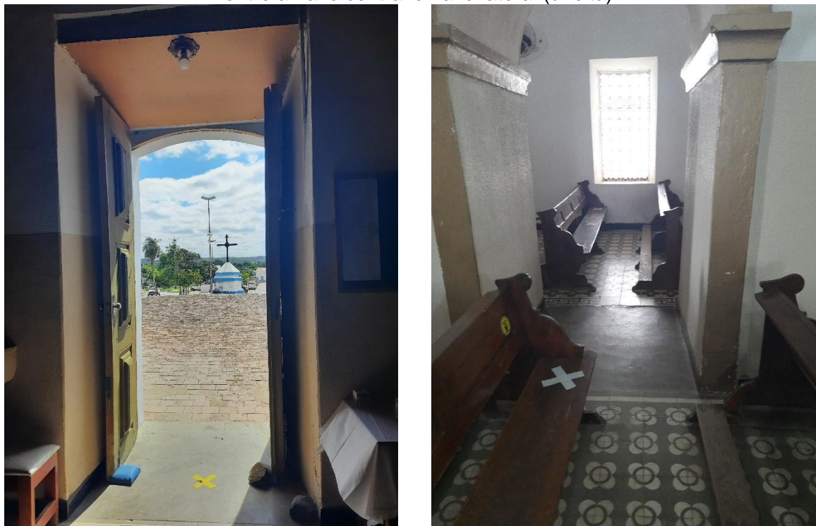
Imagem 106 - Cimentado liso (esquerda) verificado entre a porta principal e nave central e entre a nave central e nave lateral (direita).
