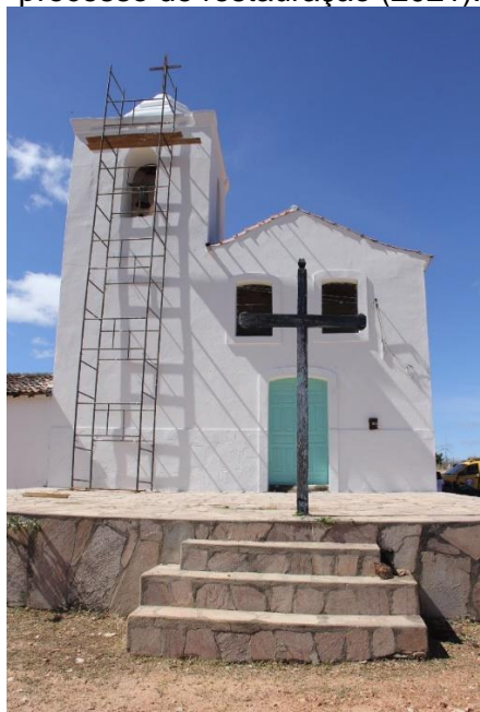
Imagem 131 - Igreja de Ponta da Serra em processo de restauração (2021).
