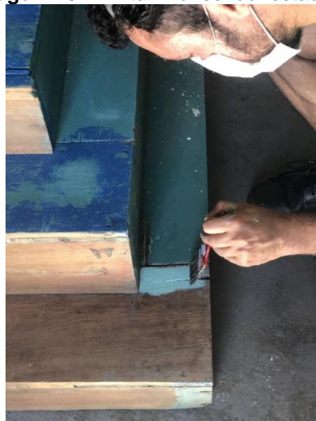
Imagem 134 – Altar-mor sendo restaurado.
