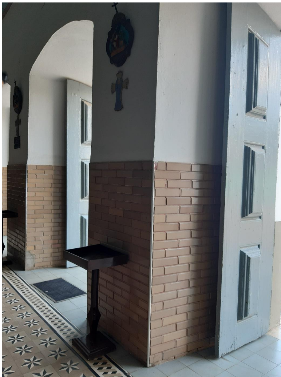
Imagem 16 - Piso cerâmico identificado na entrada da nave central.
