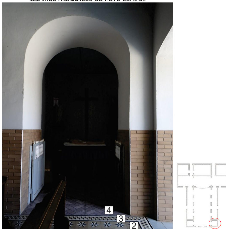
Imagem 17 - Pisos diferenciados localizados em espaço ao lado direito da nave central, e ladrilhos hidráulicos da nave central.
