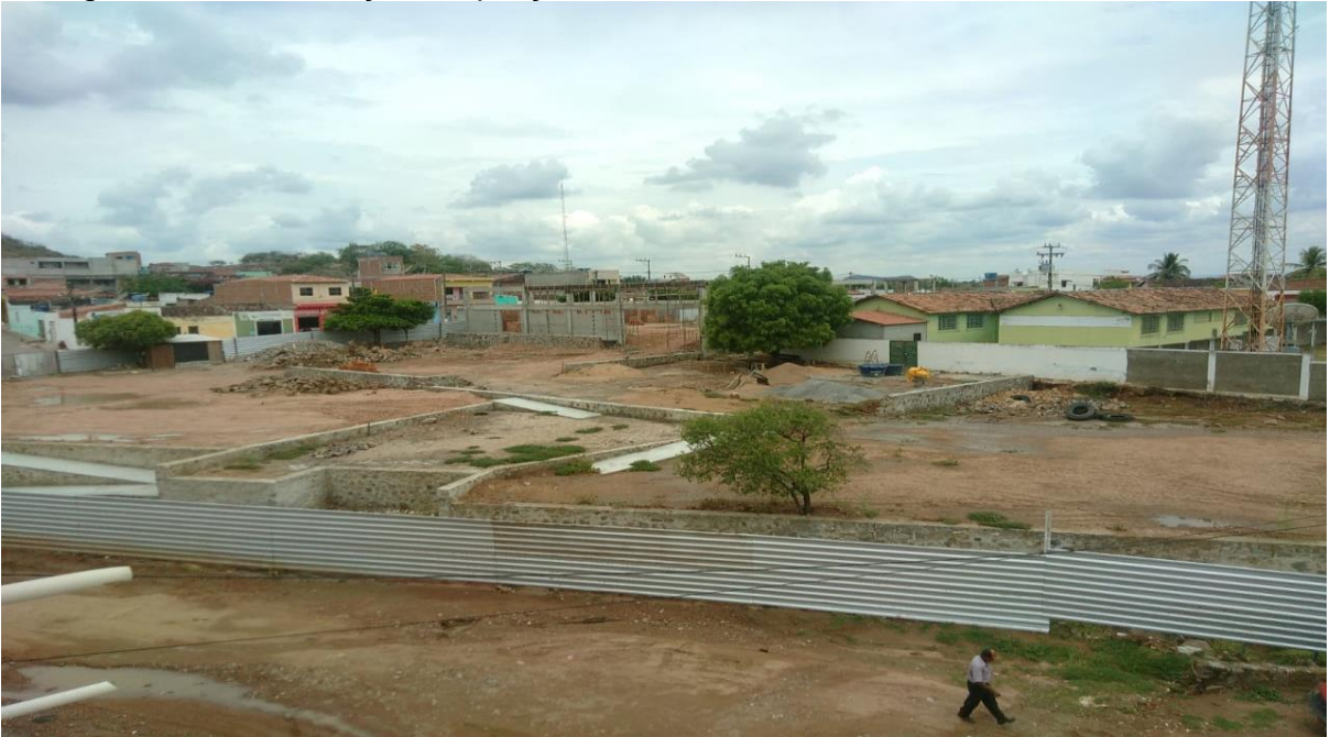
Fotografia 5 – Construção da praça da feira
