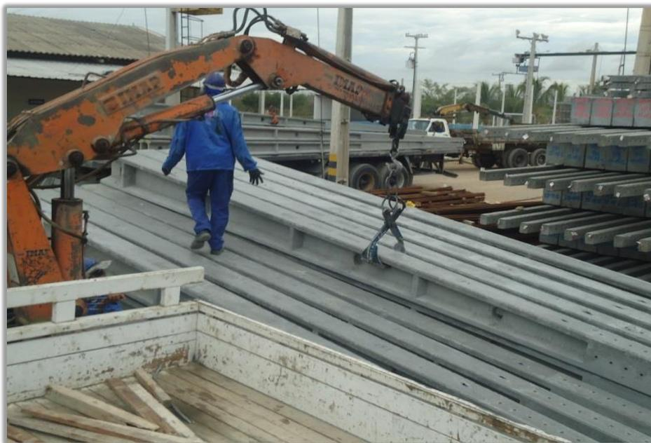
**Figura 17 - Manuseio com Garras Pantográficas**
