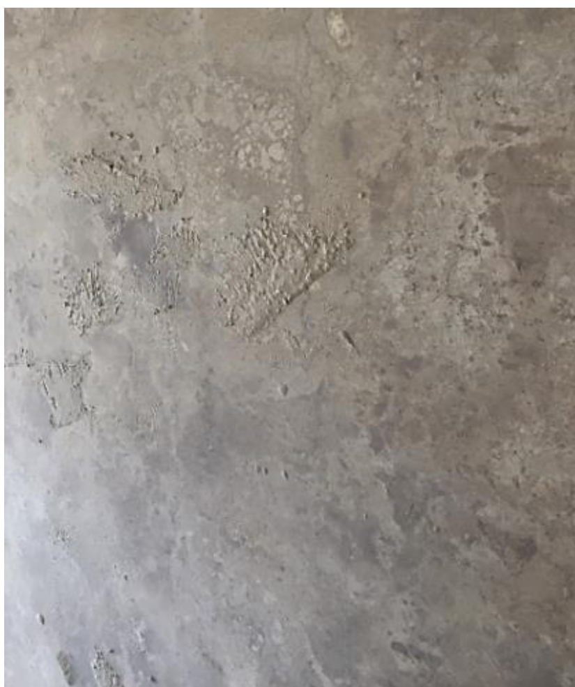
Figura 25 – Aspecto da placa após estucamento.
