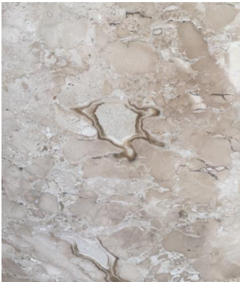
Figura 29 – Acabamento após esmerilhamento
