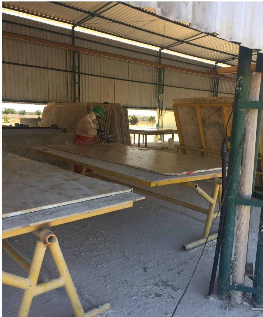
Figura 24 – Mesas retráteis para realização do estucamento
