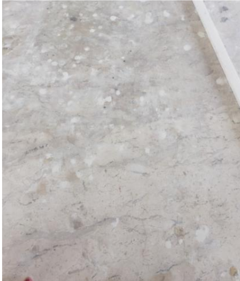
Figura 27 – Aspecto da placa após levigamento
