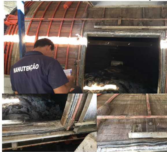
Figura 15 - Inspeção visual na estrutura do fulão (corpo do fulão)
