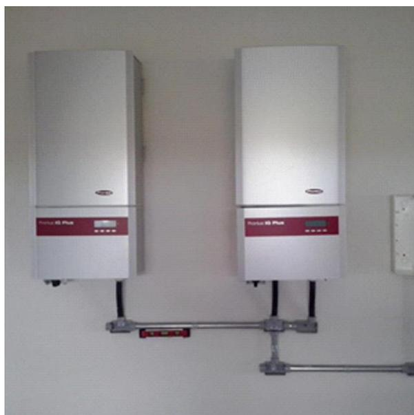
Figura 04 – Inversores de energia fotovoltaica
