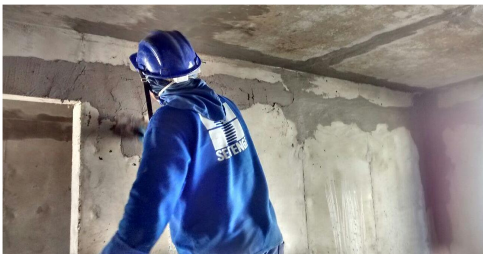
Figura 23: Regularização das Paredes Internas
