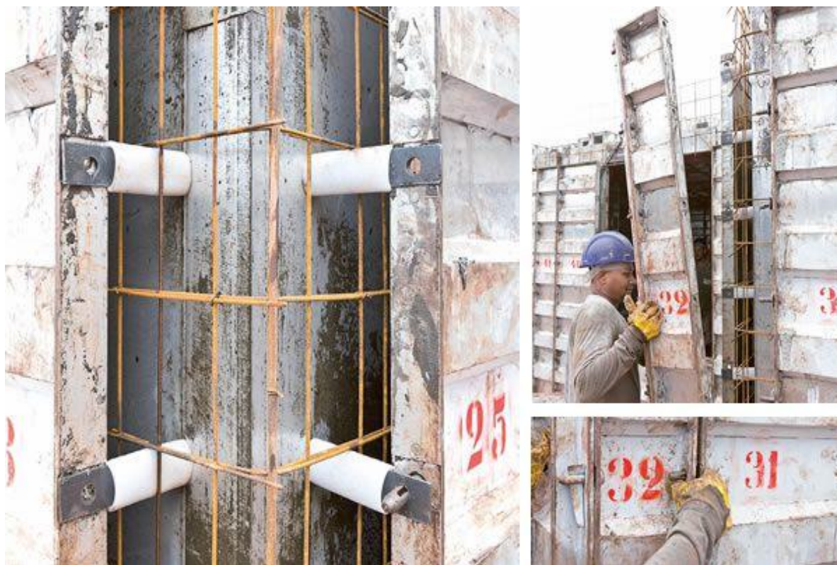
Figura 21: Ilustração da Faqueta na Placa da Fôrma
