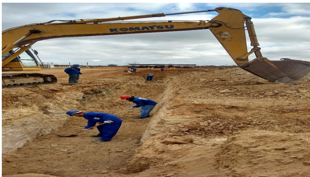
Figura 16: Ilustração da Escavação
