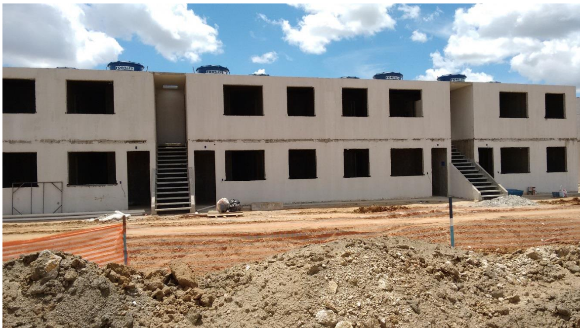
Figura 22: Pedra de Ardósia para escada, esperando a instalação do corrimão
