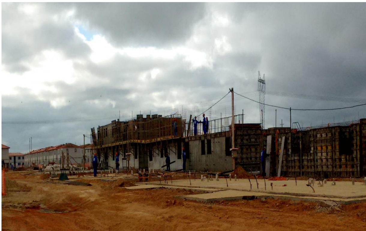
Figura 19:Fôrma Metálica, Ferragem e Concretagem
