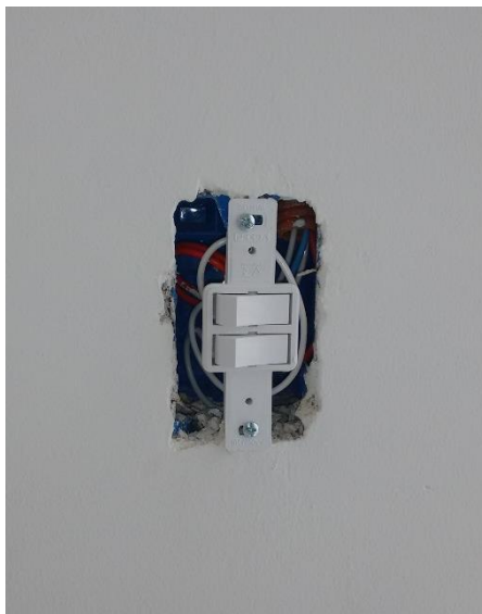
Figura 25: Ponto para eletricidade
