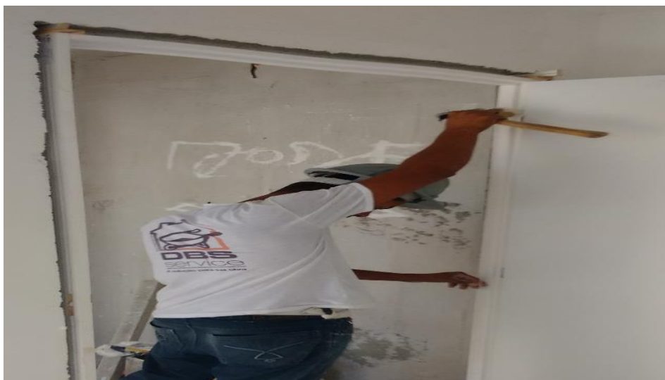
Figura 31: Instalação Esquadria de Madeira
