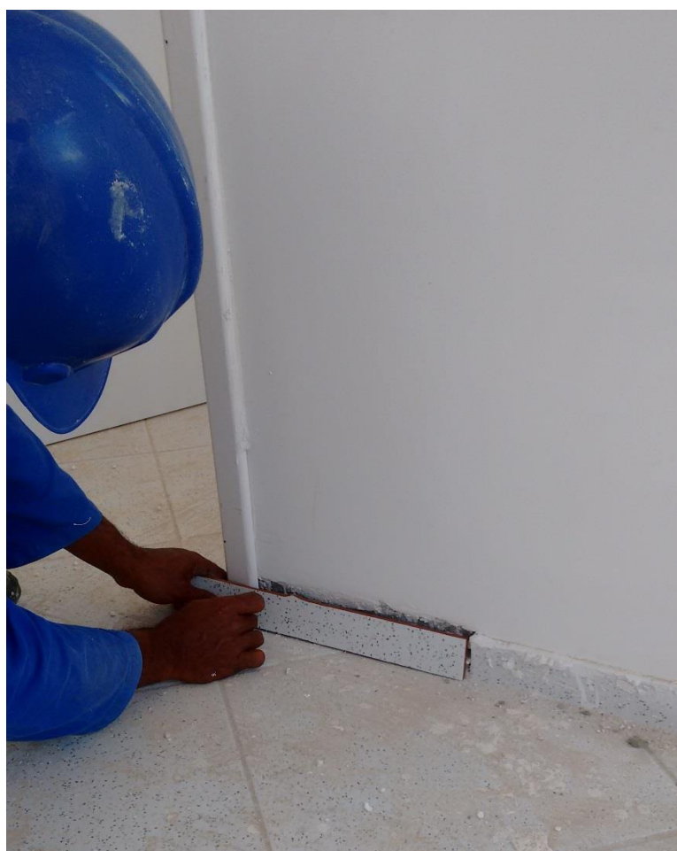
Figura 32: Arremate de Cerâmica
