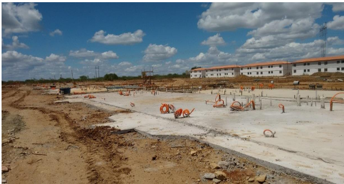
Figura 18: Demonstração da Instalação elétrica, hidráulica e solo e cimento
