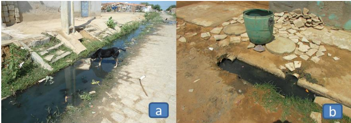
Figura 7 - (a) Esgoto a céu aberto no bairro Codevasf; (b) Esgoto a céu aberto no bairro João Paulo II.
