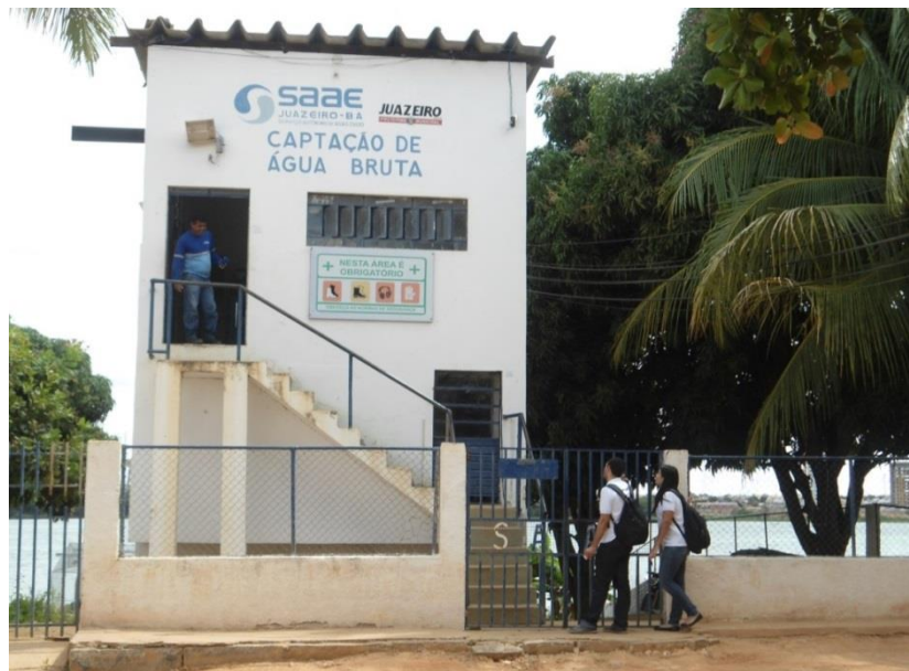
Figura 4 - Estrutura de captação de água.
