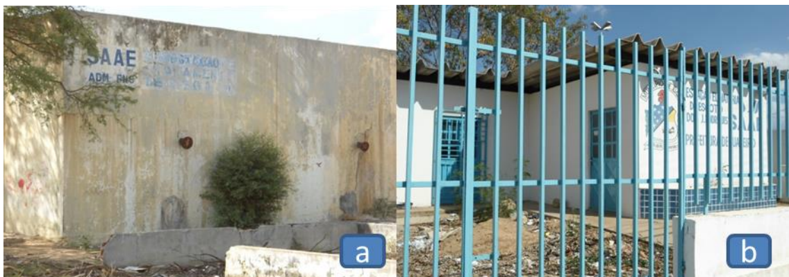
Figura 9 - (a) Estação de tratamento de esgoto desativada no Dom José Rodrigues. (b) Estação elevatória em funcionamento no Dom José Rodrigues.
