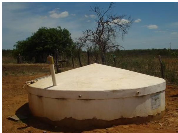
Figura 8 - Cisterna rural de 16m 3
