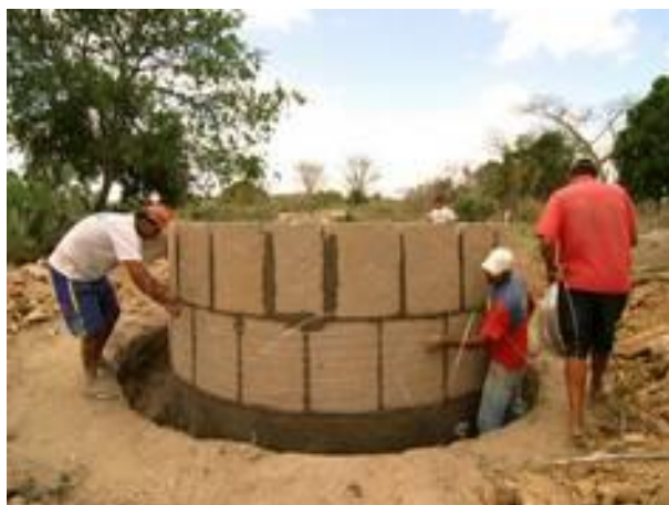
Figura 7 - Construção de cisterna de placas no meio rural
