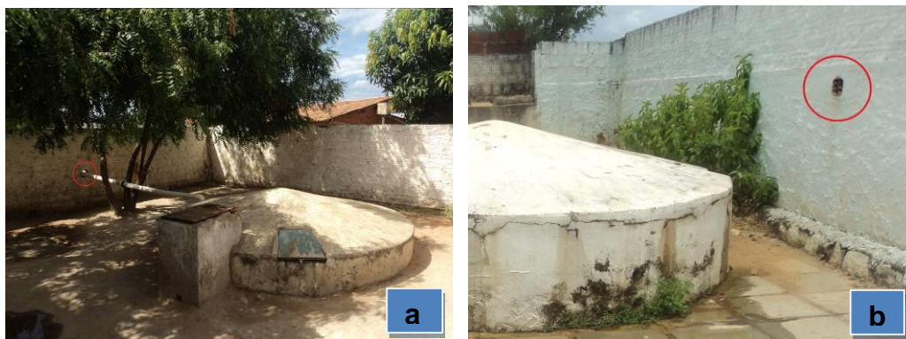
Figura 16 - Abertura em muros das escolas para abastecimento de cisternas com água de carro-pipa
