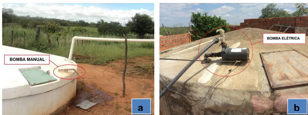
Figura 18 - (a) Bomba manual para retirada da água, (b) Bomba elétrica para retirada da água
