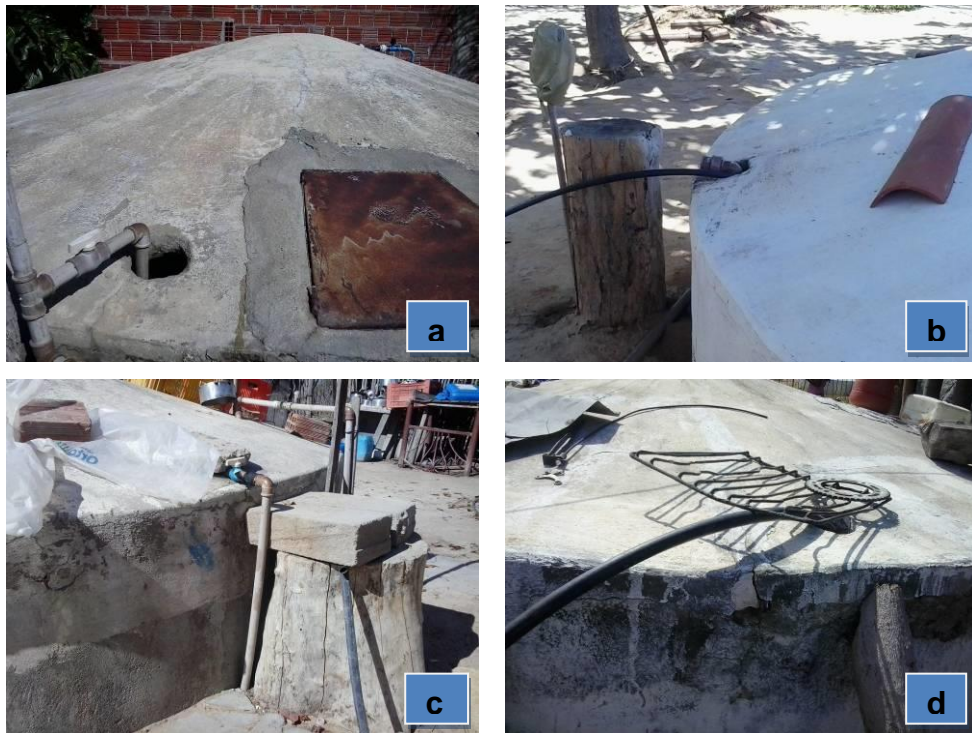
Figura 21 - (a-b-c-d) Abertura em cisternas para entrada da tubulação para abastecimento com água de canal, na localidade de Sítio Porteiros-PE
