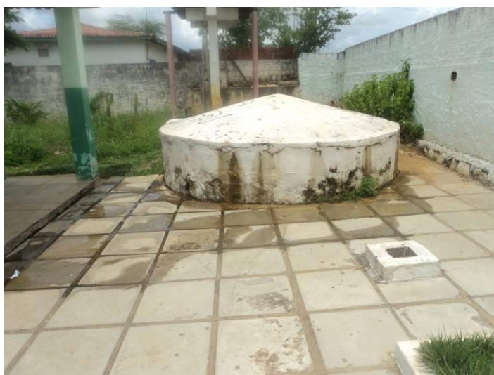
Figura 31 - Calçada em cisterna escolar
