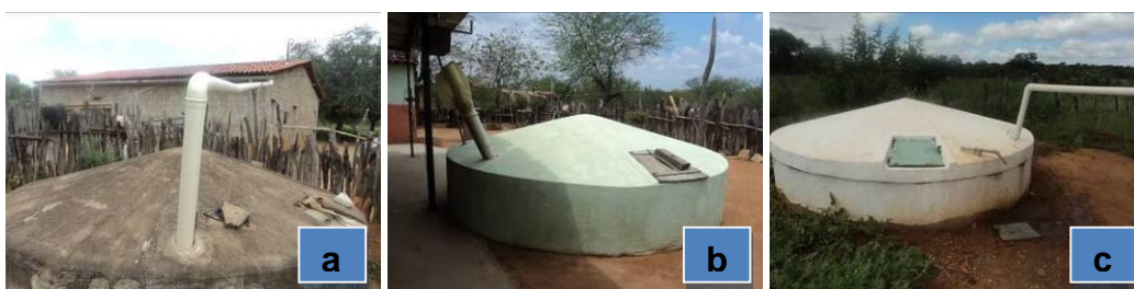
Figura 36 - (a) Cisterna sem pintura, (b) Cisterna pintada de verde e (c) Cisterna pintada de branco
