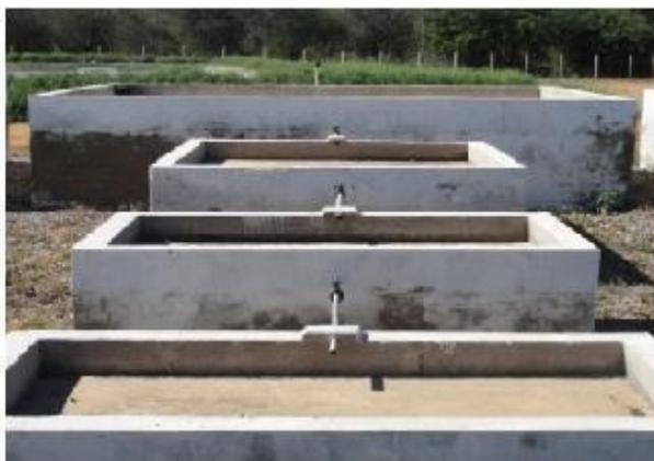
Figura 3. Tanques utilizados para cristalização de água salina
