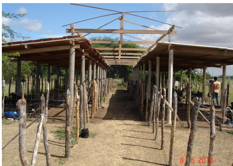
Figura 5. Aprisco coberto com telha de cimento amianto (direita) área coberta com telha de cerâmica (esquerda).
