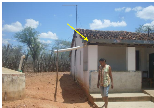
Figura 32: Presença de calha coletora na localidade de Lagedo - PE.
