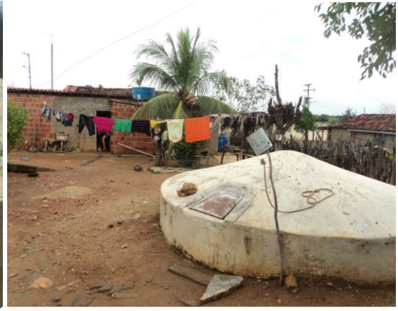
Figura 27: Aspecto de manejo referente à retirada da água de cisterna rural na localidade de Cristália - PE.
