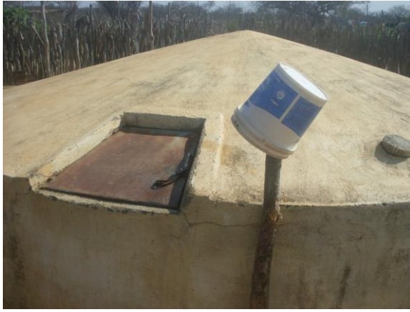
Figura 26: Aspecto de manejo referente à retirada da água de cisterna rural na localidade de Assentamento Esperança- PE.
