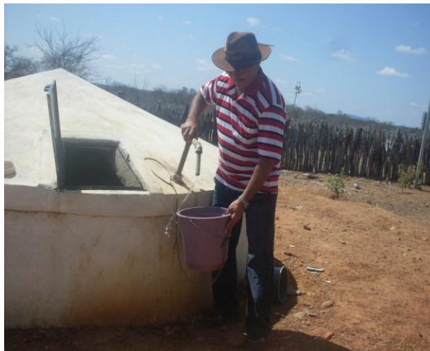
Figura 28: Aspecto de manejo referente à retirada da água em cisterna rural na localidade de Lagedo - PE.
