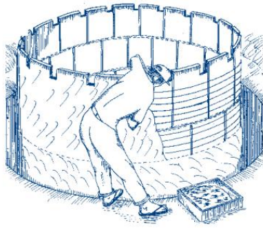
Figura 02: Armação da parede e reboco externo de cisterna de placa. (GNADLINGER, 1999)
