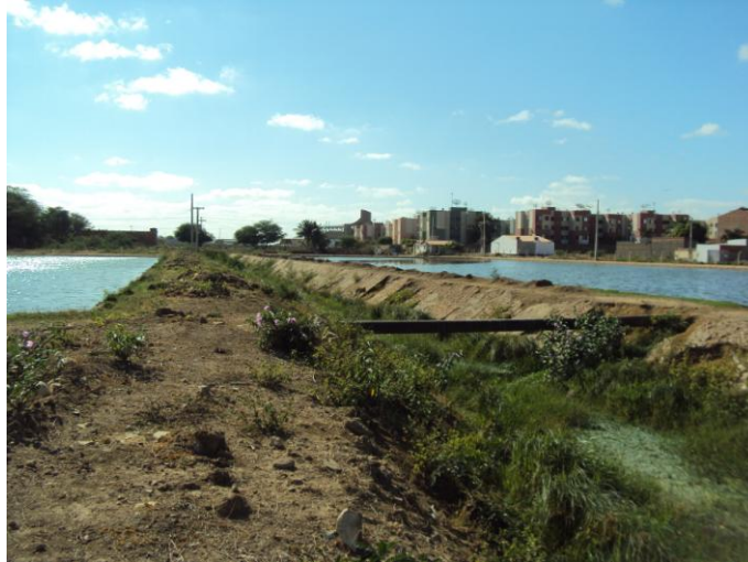
Figura 10: Sistema de tratamento de esgoto.
