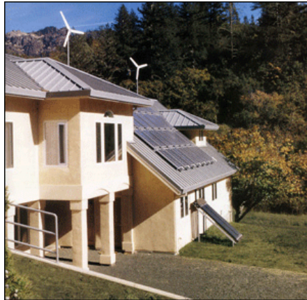
Figura 5.1 - Aplicação da microgeração distribuída em unidade residencial.
